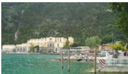
Fig. 11 - La centrale idroelettrica a Riva del Garda; lo sviluppo genera spesso strutture che rappresentano progetti condivisi e proiettati nel futuro della comunità, e dominano il paesaggio, concorrono quindi a dare immagine alla sua nuova identità
